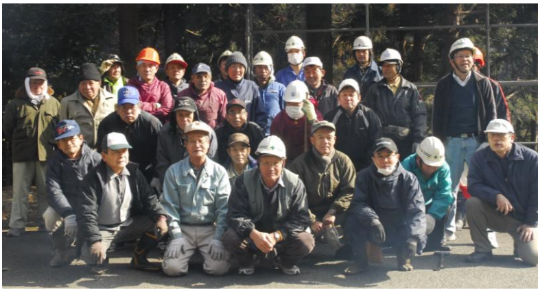
お世話になったバス停、駐輪場の解体作業に協力した人々
