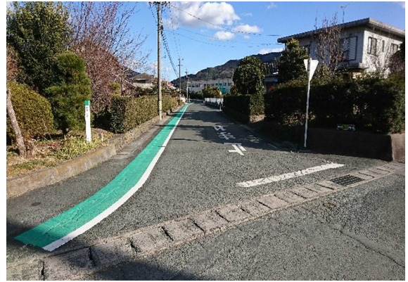
路肩カラー塗装設置
