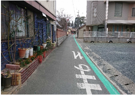
路肩カラー塗装設置
