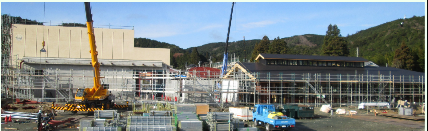
▲急ピッチで進む建設工事
