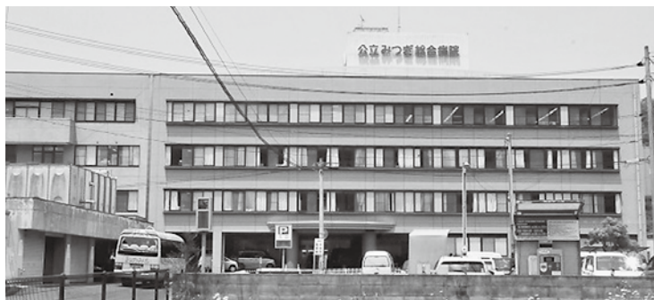
公立みつぎ総合病院 外観
