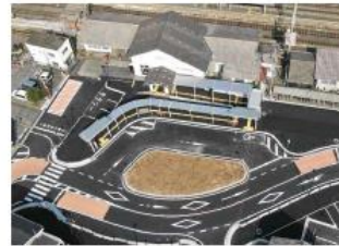
新城駅前広場の暫定整備
