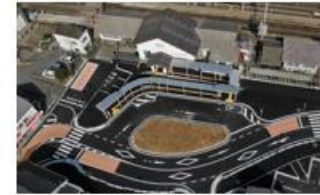
新城駅前広場の暫定整備
