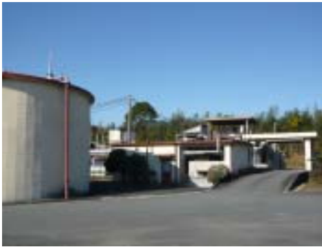
新城市清掃センター
