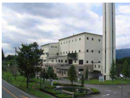
新城市クリーンセンター
