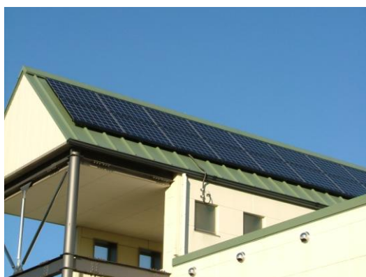
八名幼稚園の屋根に設置されている太陽光パネル
