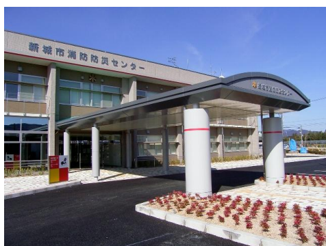
新城市消防防災センター（平井地内）
