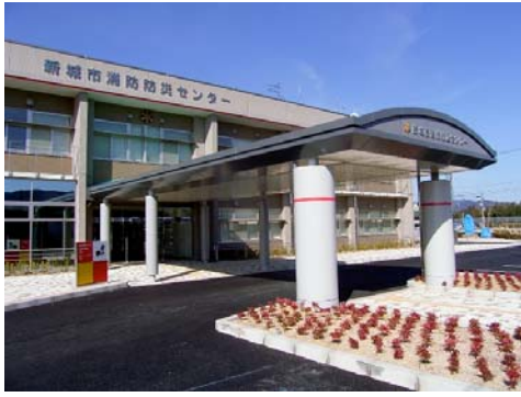
新城市消防防災センター（平井地内）
