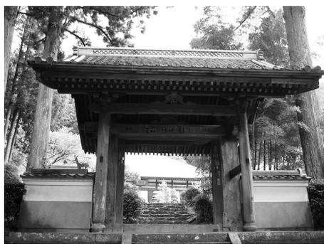
天明2（1782）年火災によって本堂はじめ大部分の建物は焼失しましたが、この山門は難を免れ、現在に至っています。四脚門、切妻造り、瓦葺屋根、本柱は角柱、控柱は円柱、両開板戸で、間口2・6m、高さ7m、奥行き3・5mです。構造材、板戸はケヤキ材が使われています。この山門は昭和46年6月12日に市（町）文化財に指定されました。ただし、袖扉はコンクリート製で原形をとどめていません。昭和54（1979）年、屋根葺替工事を実施しました。
