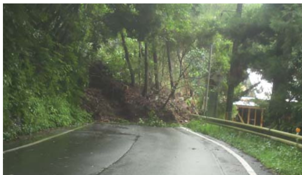
▲県道豊橋乗本線（乗本地内）の土砂崩れ （8月4日現在も通行止めが続いています）
