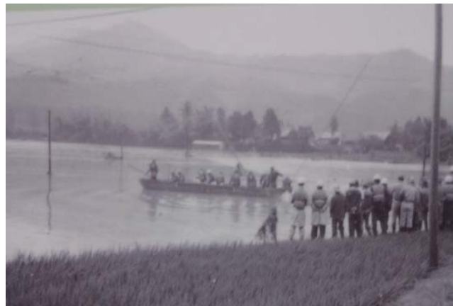
▲昭和43年に豊島地区が浸水した様子
