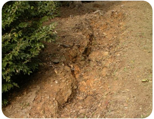
9 三河地震による地割れ (蒲郡市: 市指定天然記念物) 1945年に発生した、三河湾を震源とする地震による地割れ跡が、宗徳寺の裏に残っています。
