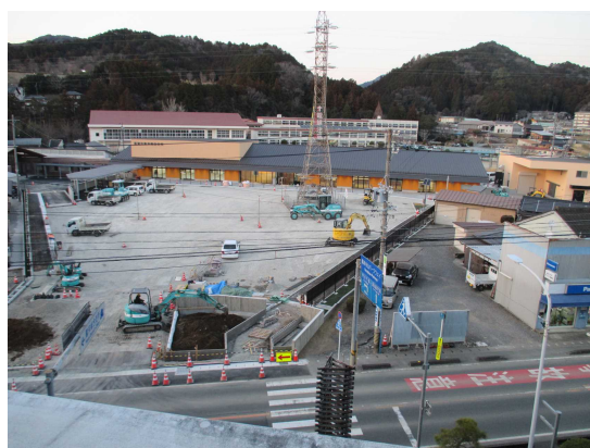
(工事中の新鳳来総合支所)
